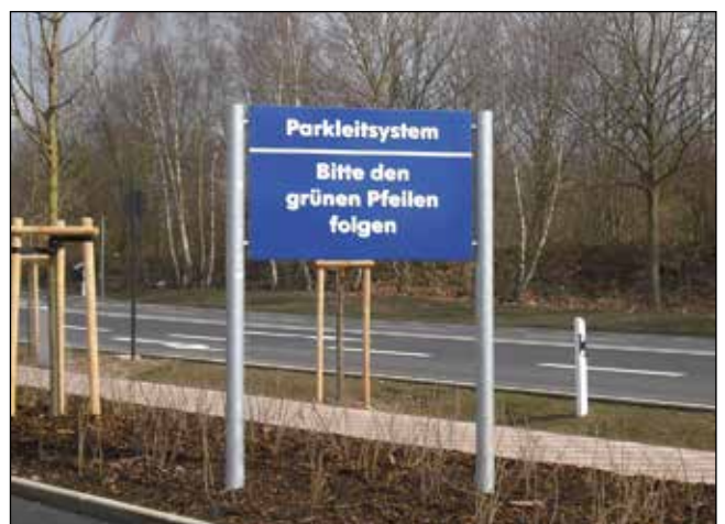
Hinweisschild 1.00 x 500 mm mit verzinkten Standrohren, Fundamentmontage
