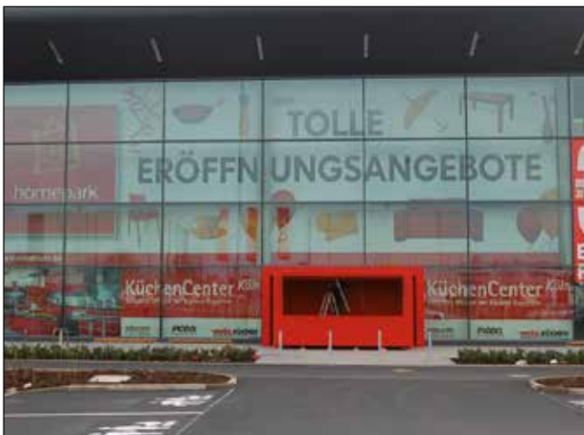
Kederschienen-System an Glasfassade
