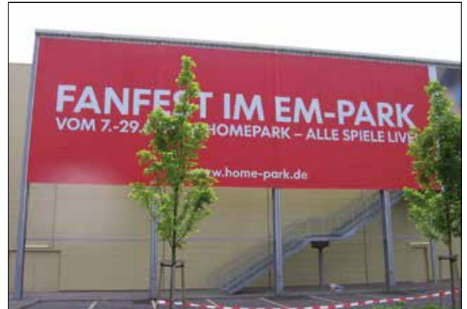
Liftersystem (34 x 7 mtr.) auf Stahlkonstruktion
