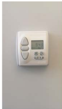
Zeitschaltuhr auf Funkbasis Zum automatischen Auf- und Ablassen der Banner in der SB-Halle.
